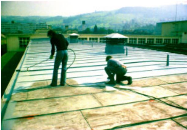
Landis + Gyr AG Zug, Falzblechdach-Abdichtung, Blechstossarmierung mit Elastic Band, ( 2400 m2 )
